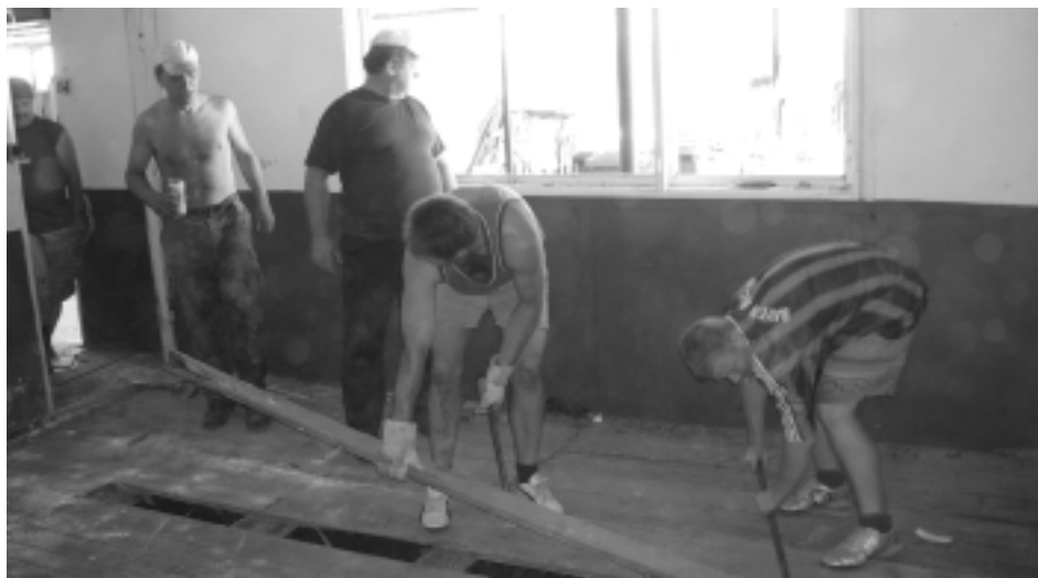
Sympatycy LKS w trakcie prac remontowych
