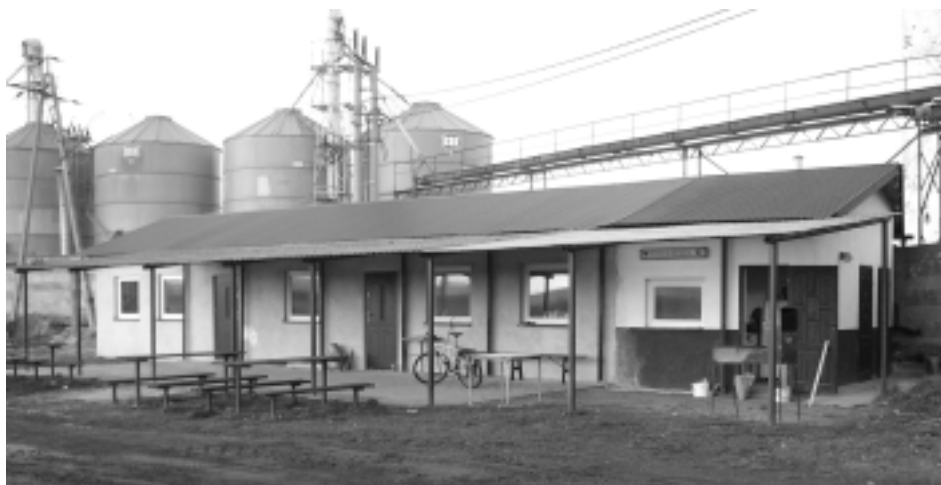
Budynek LKS po remoncie
